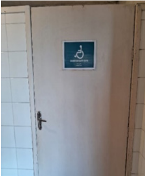
Figura 5. Entradas Banheiros do Prédio 1
